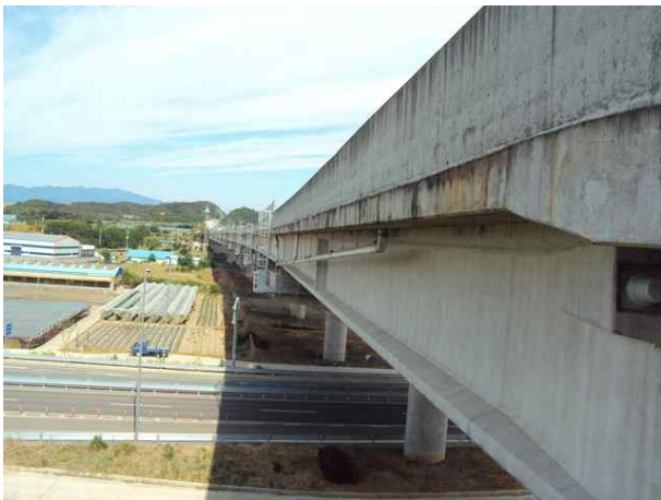
9공구 고현천교 (9공구)
