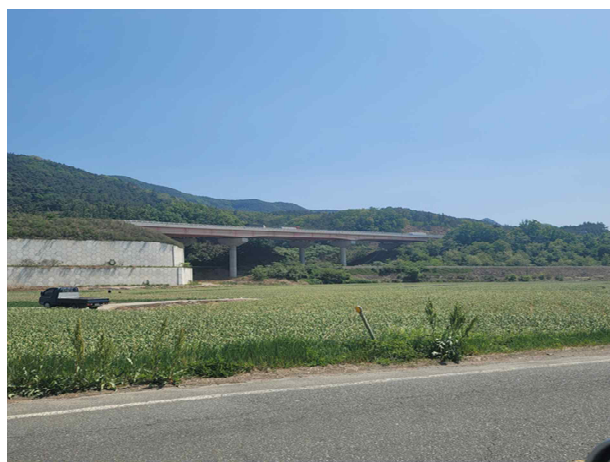
7공구 화남교 (7공구)
