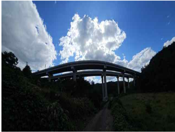
5공구 불당교 (5공구)
