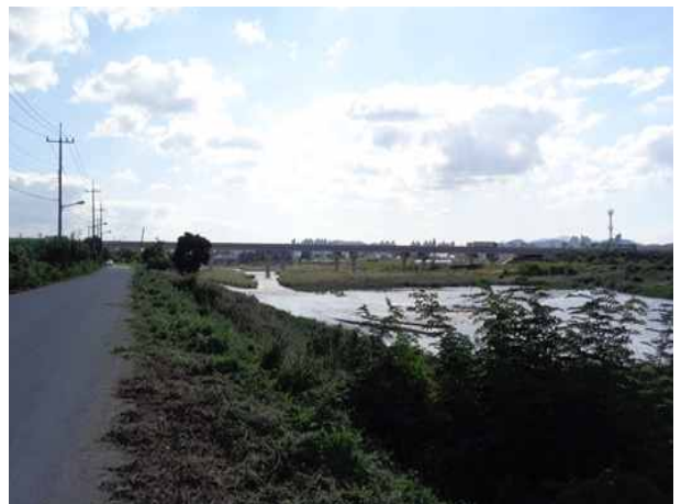
10공구 산하교 (10공구)
