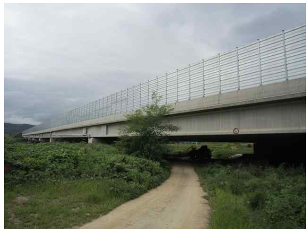
6공구 금매교 (6공구)
