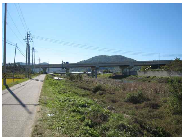
3공구 신계교 (3공구)
