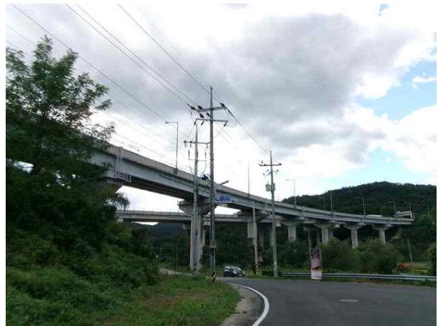
5공구 군위JCT R-C교 (5공구)
