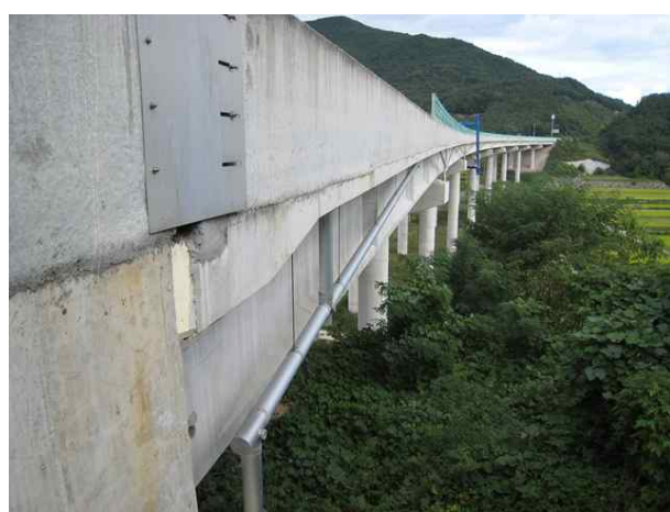
3공구 도개교 (3공구)
