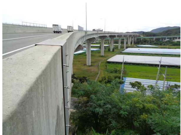
10공구 영천JCT Ramp-B교(10공구)
