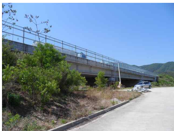
7공구 배골교 (7공구)
