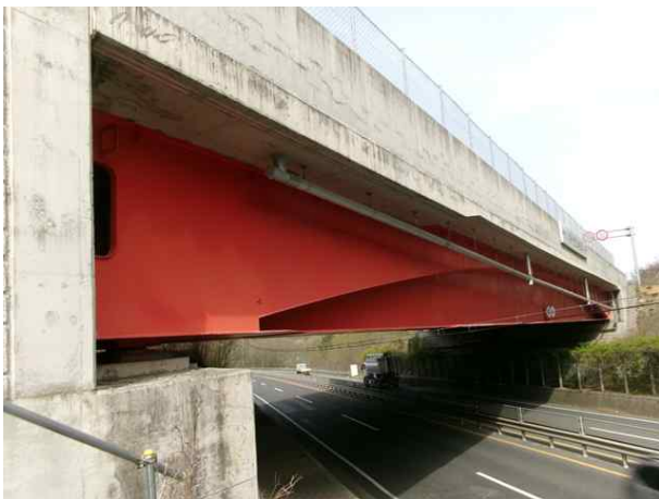
9공구 오미교 (9공구)
