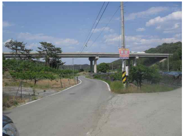
9공구 도림천교 (9공구)
