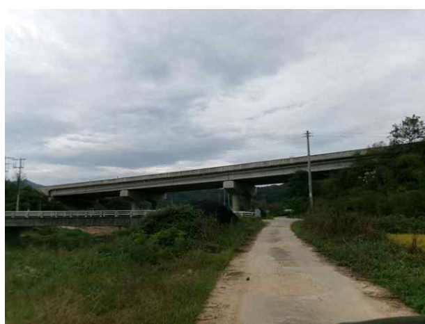
2공구 월가교 (2공구)
