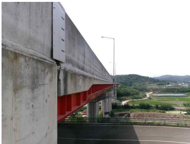
8공구 화산JCT RAMP-A1교(8공구)
