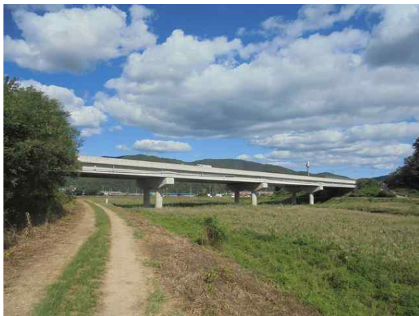
6공구 장기교 (6공구)
