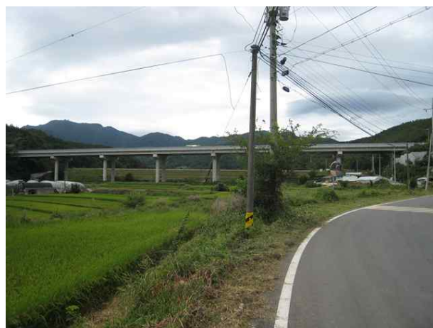
7공구 산성교 (7공구)
