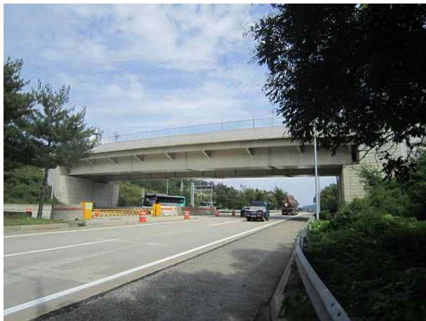
5공구 군위JCT R-A4교 (5공구)
