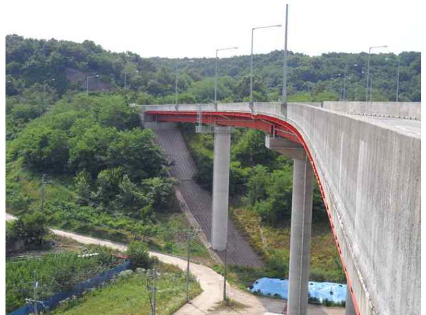
8공구 화산JCT RAMP-H교(8공구)
