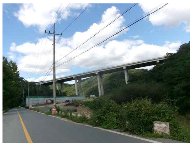
5공구 오실교 (5공구)
