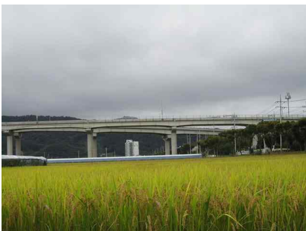
10공구 영천JCT Ramp-A교(10공구)
