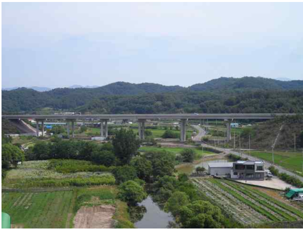
9공구 가래실교 (9공구)
