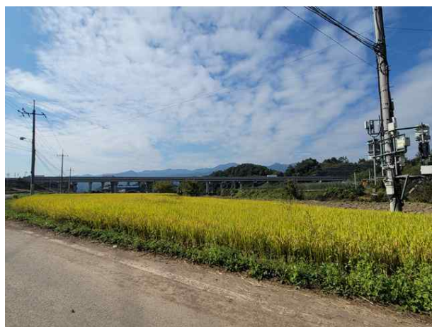
6공구 가호교 (6공구)
