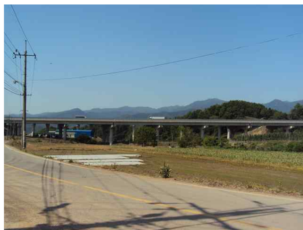
8공구 가천교 (8공구)
