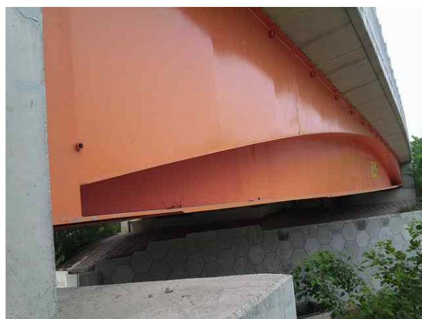
7공구 화남1교 (7공구)
