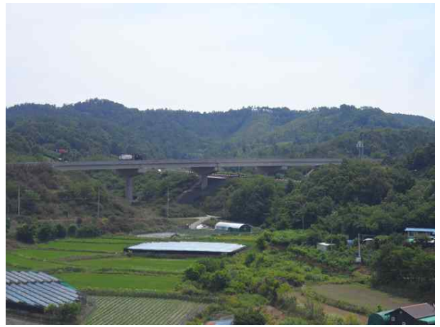
9공구 암기교 (9공구)
