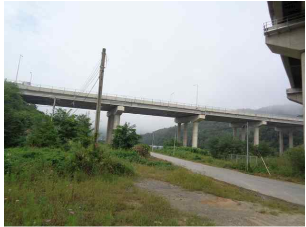
5공구 내리교 (5공구)
