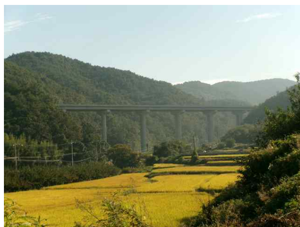
4공구 산호교 (4공구)
