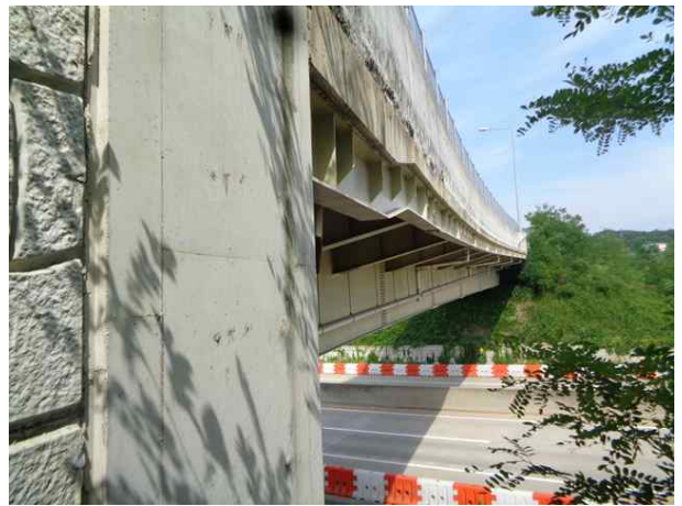
8공구 화산JCT RAMP-A교(8공구)
